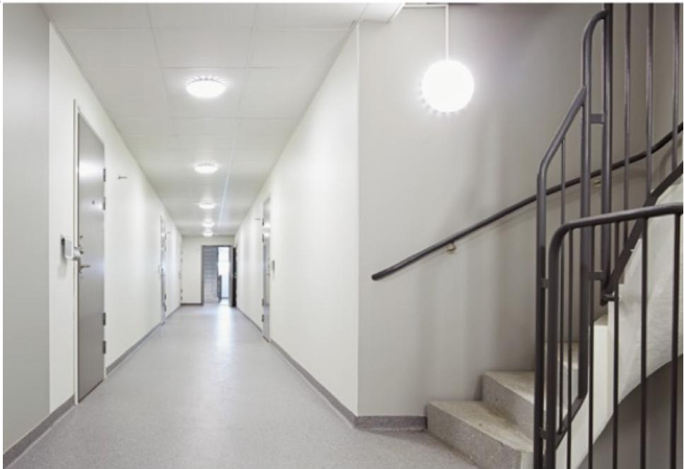
Lampa are incorporat complet sub abajur un senzor de miscare performant ce actioneaza pe o raza intre 1 si 8 ml, acoperind o suprafata de aproximativ 50 mp.
